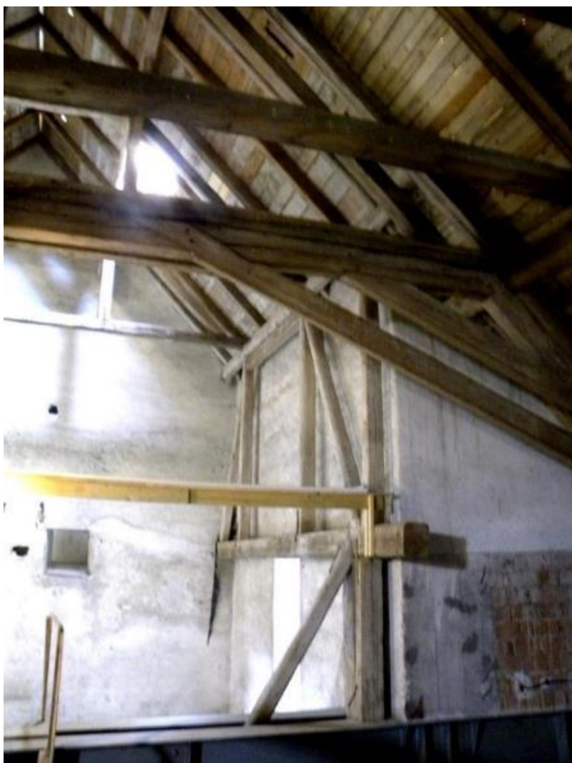
Fotografie č. 8: Obnovená část střech (vnitřní pohled), obnova z let 2014–2015
