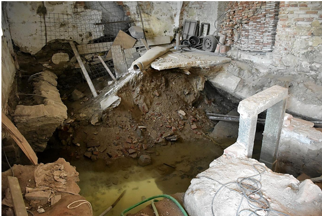
Fotografie č. 6: Neobnovená vnitřní část zámku
