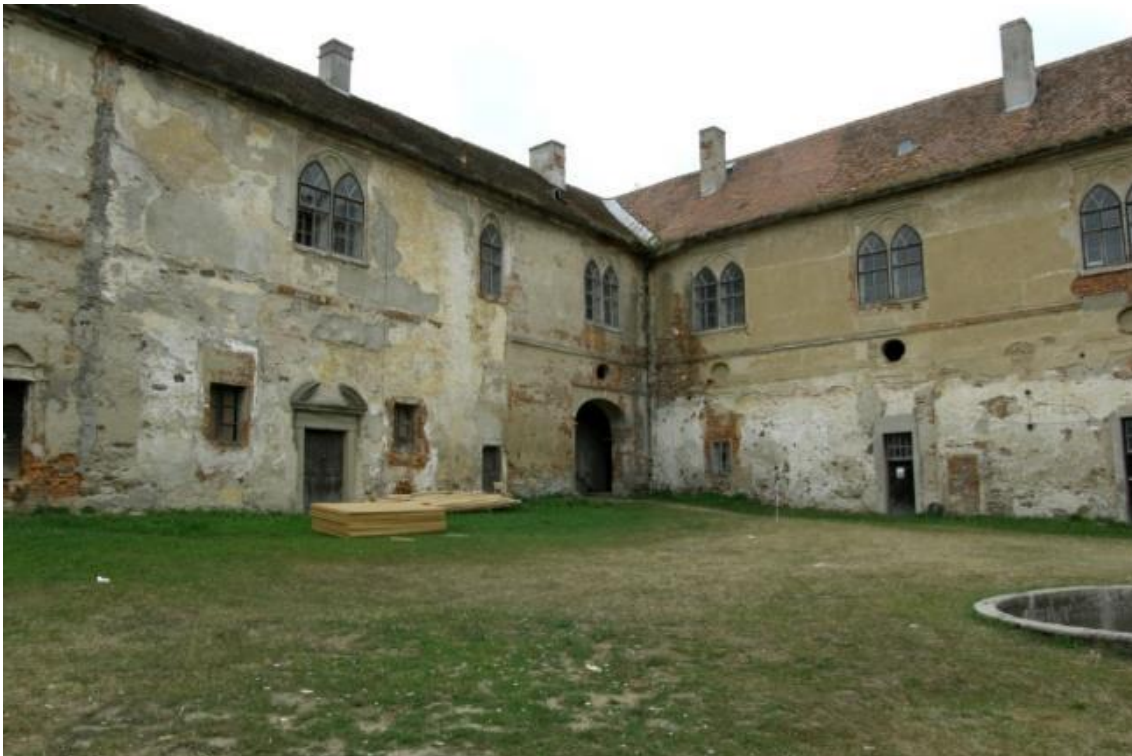
Fotografie č. 12: Neobnovená část zámku
