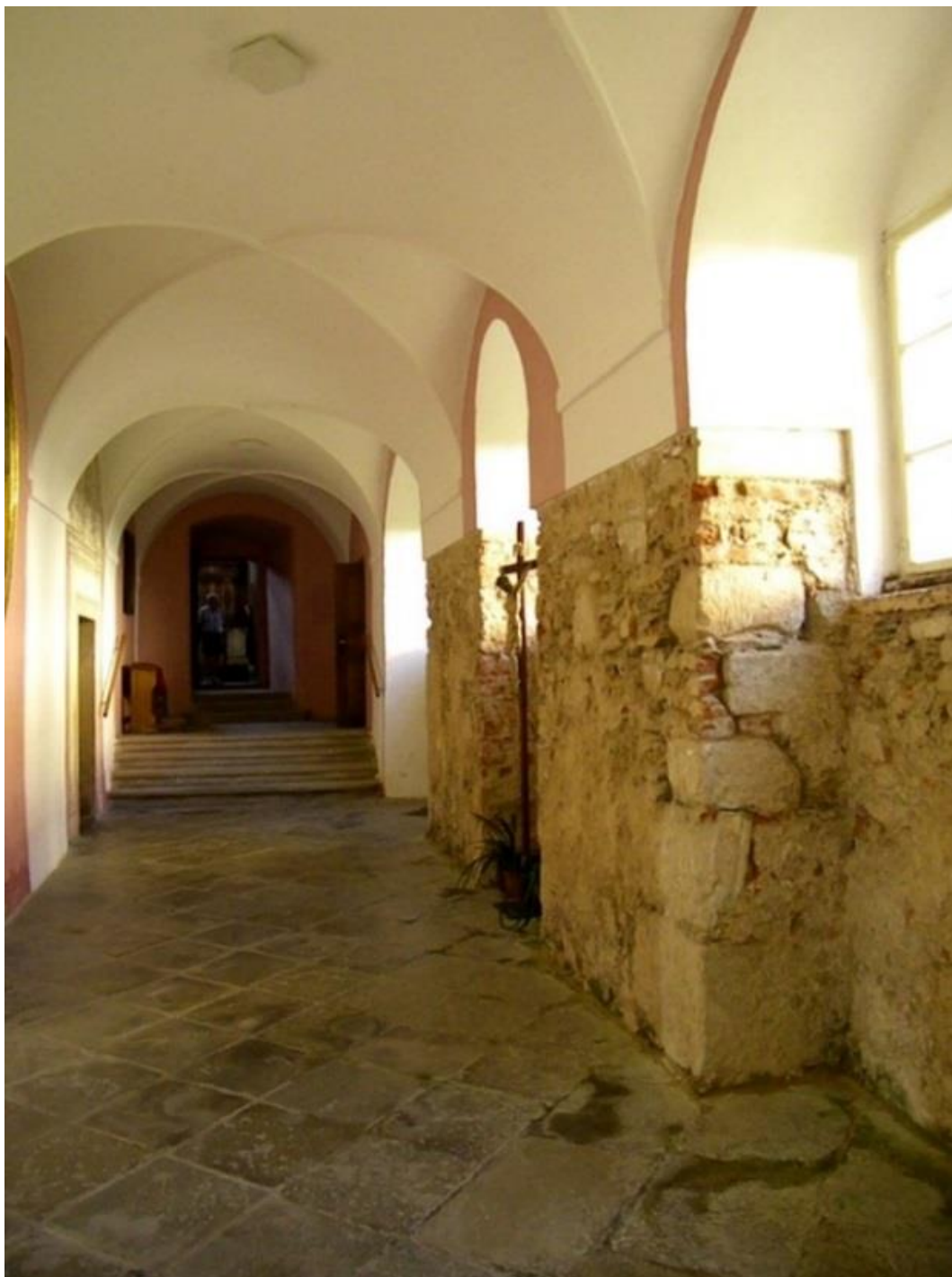
Fotografie č. 3: Neobnovená část areálu kláštera (obnova kamenné dlažby)
