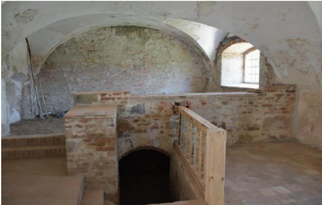
Fotografie č. 5: Obnovená vnitřní část zámku
