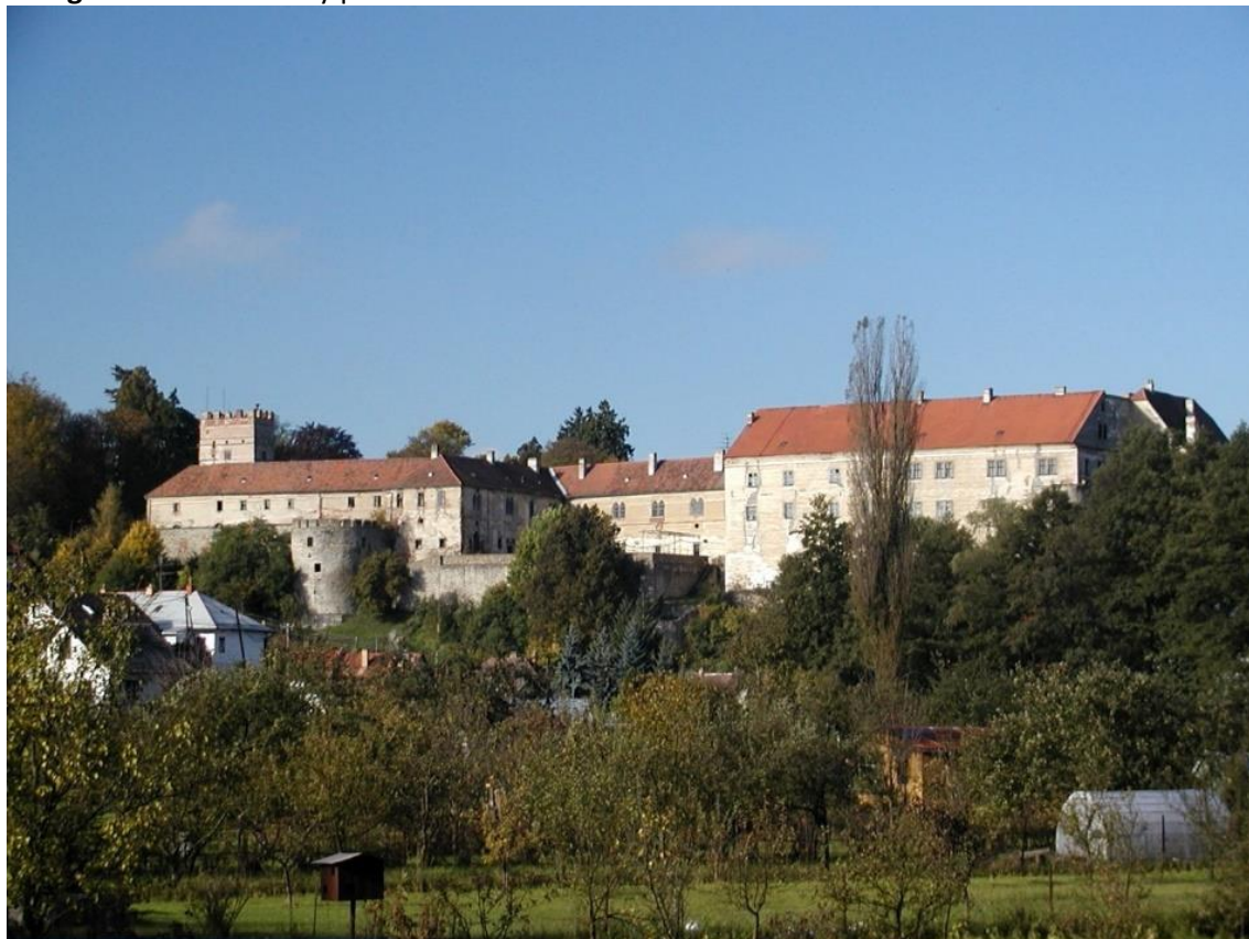
Fotografie č. 10: Celkový pohled na zámek Brtnice
